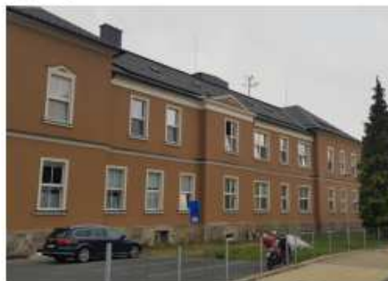
Nemocnica Červená voda 333
