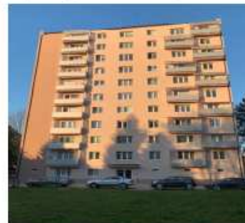
Bytový dom, Stodolu 8, Prievidza
