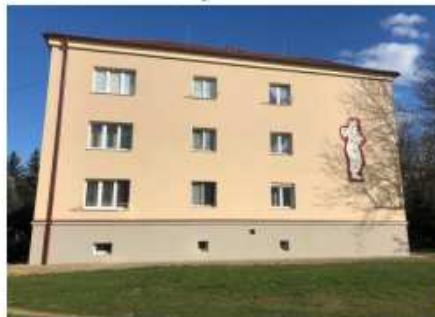
Bytový dom, J. Siváka 2-4, Prievidza
