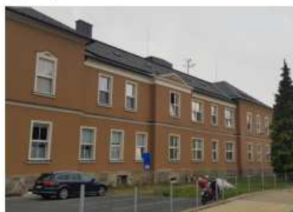
Nemocnica Červená voda 333
