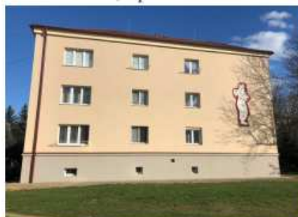
Bytový dom, J. Siváka 2-4, Prievidza
